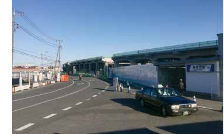
野田市駅部 高架橋施工状況
