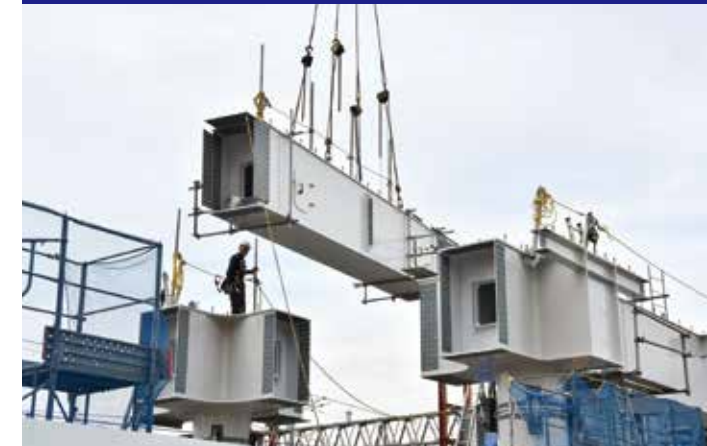
高架橋新設工事(高架橋桁架設)
