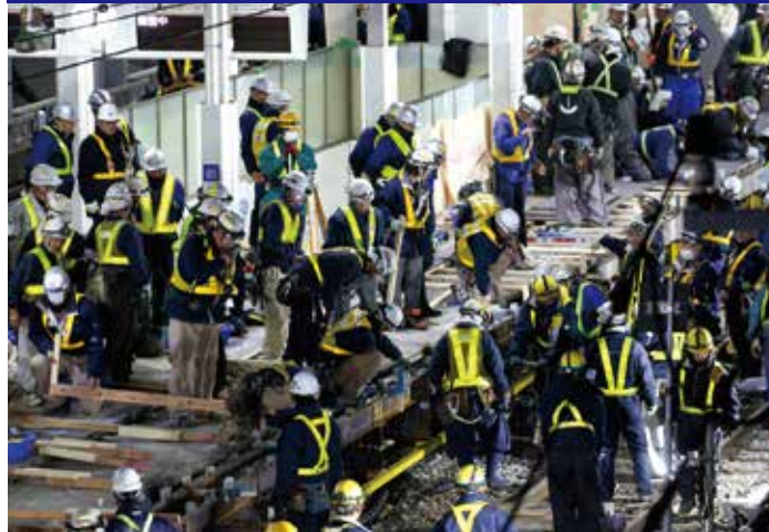
とうきょうスカイツリー駅部 仮ホーム設置状況
