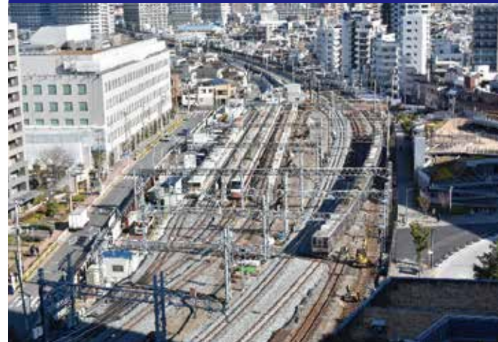
曳舟～とうきょうスカイツリー間 切替工事後の状況
